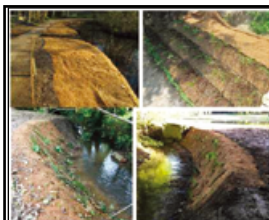
Reprises de berges avec différentes techniques issues du génie végétal
